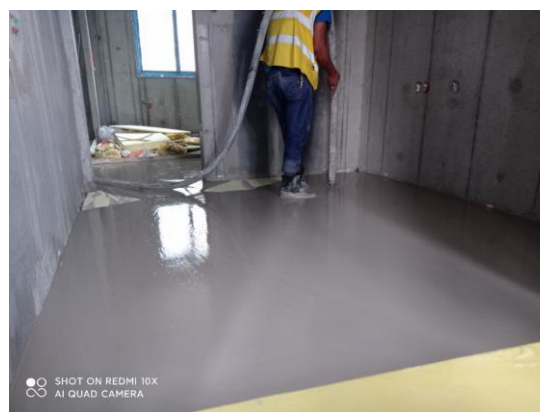
图 1.4 非地暖地面保温找平系统-石膏基地面找平砂浆回填找平
