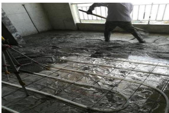
图 3.11 细石混凝土回填找平
