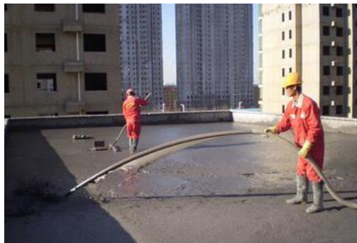
图 3.2 屋面回填找平
